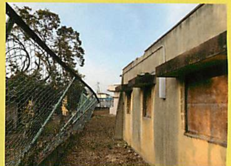
倒木の処分後
