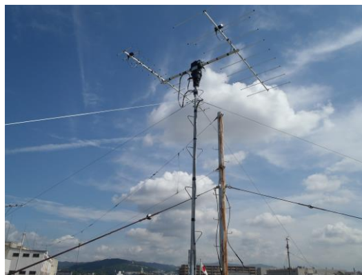
図5 電波塔設置完了
