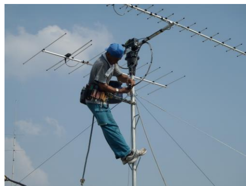
図4 ローテーター設置中
